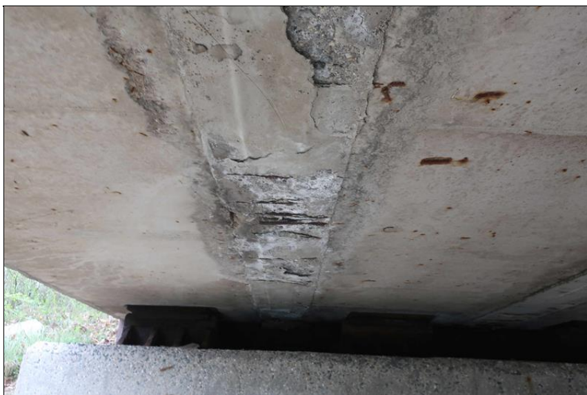
stopy po průsacích s výluhy pojiva na spodním líci spáry mezi 1. a 2. nosníkem před O4
