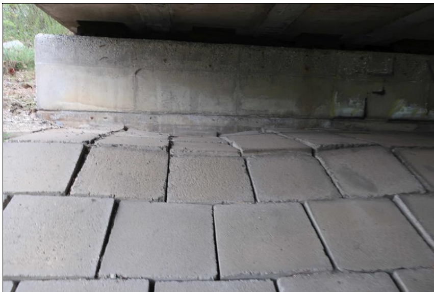
deformace svahu pod dlážděným krytem před O4
