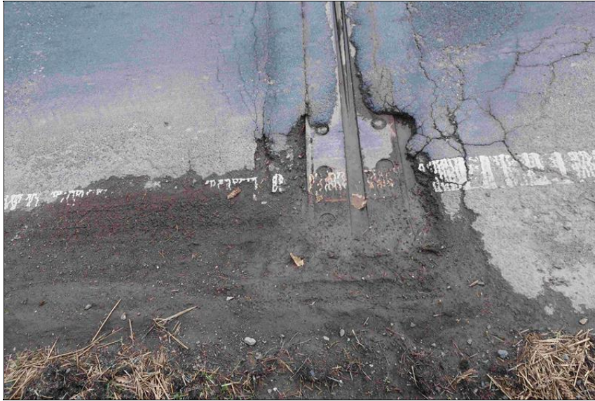
zanesený MZ O1 u pravého chodníku
