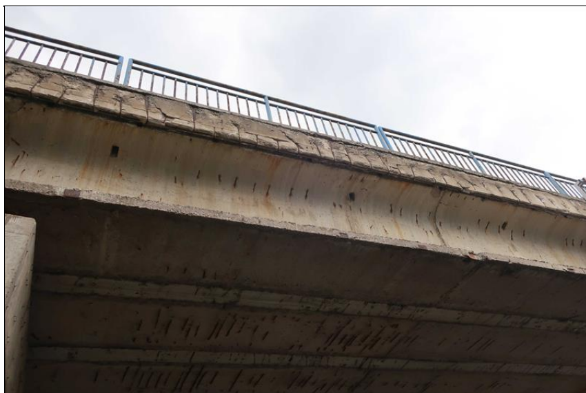
detail poruch levé římsy
