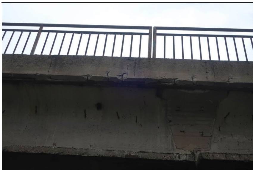
separace krycí vrstvy nad korodující výztuží u pravé římsy
