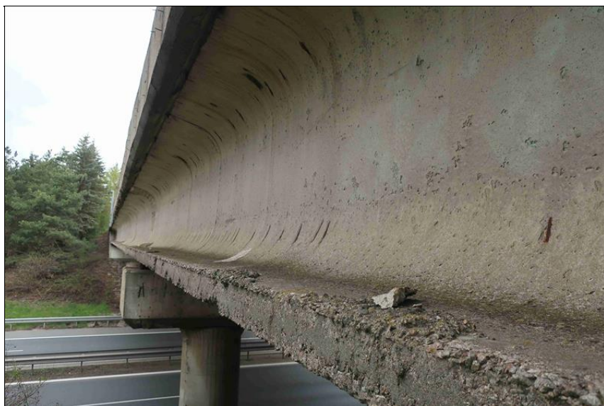
degradace betonu na vnějším boku 9. nosníku ve 3. poli
