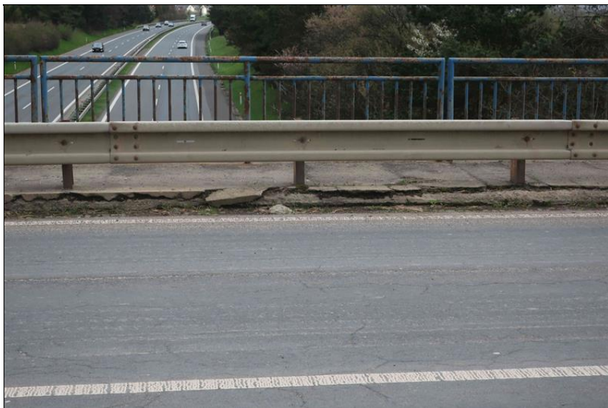
rozpad betonu levého chodníku
