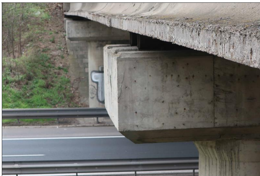
uložení NK na P2 vlevo trhlina v hraně stativa
