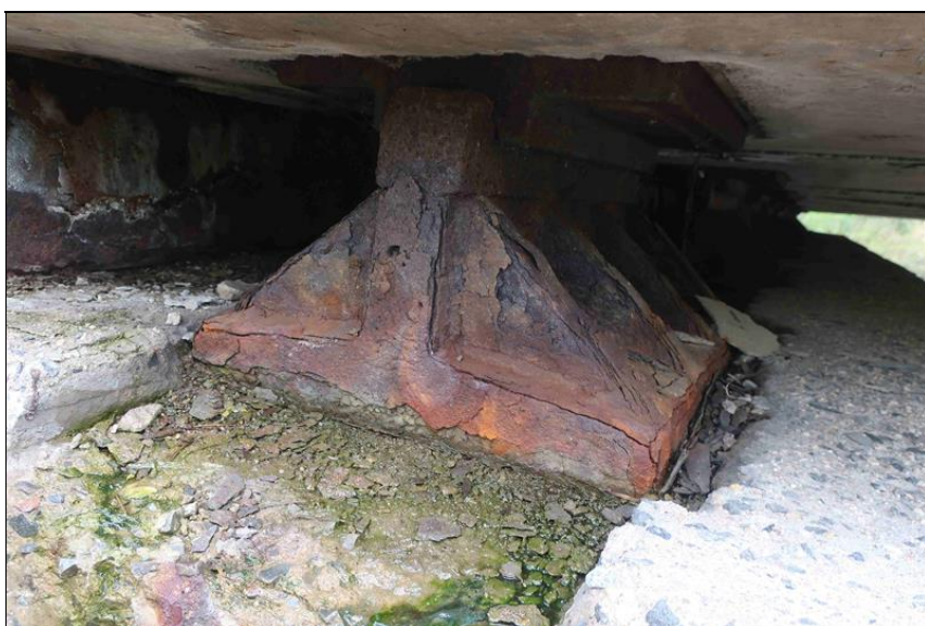
koroze 1. ložiska O4
