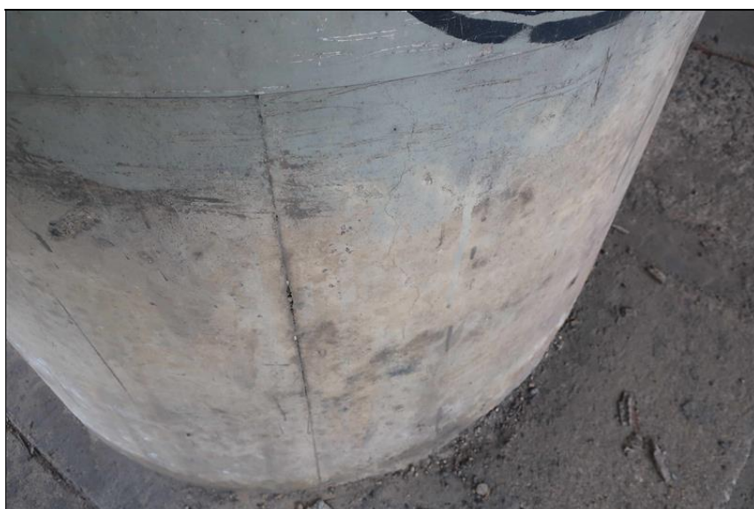
nepravidelné zavhlé trhliny na líci stojky P2
