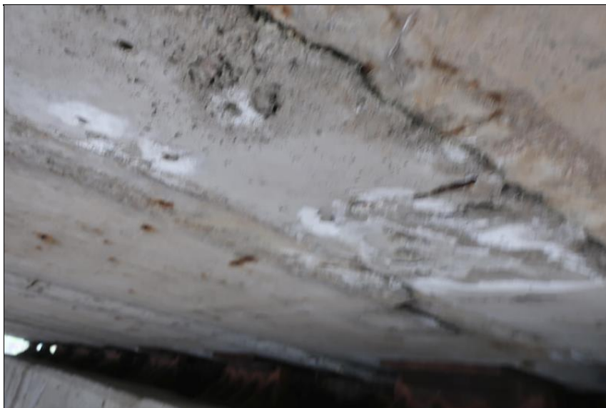
stopy po průsaku sparou mezi nosníky u O4
