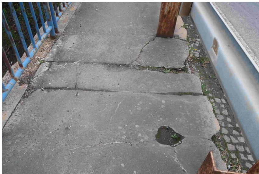
trhliny v krytu levého chodníku degradace betonu římsy
