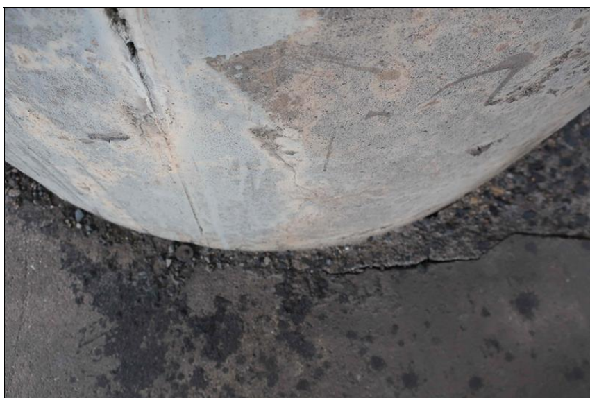
nepravidelné zavhlé trhliny na líci stojky P3
