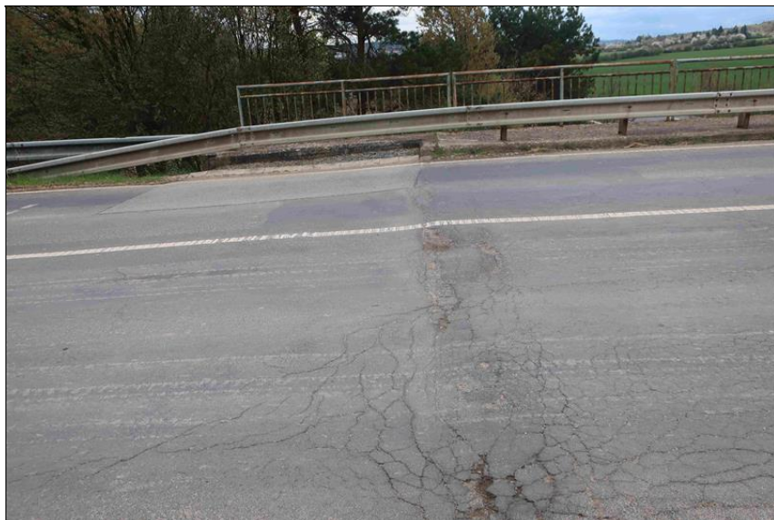
rozpad krytu vozovky nad O4
