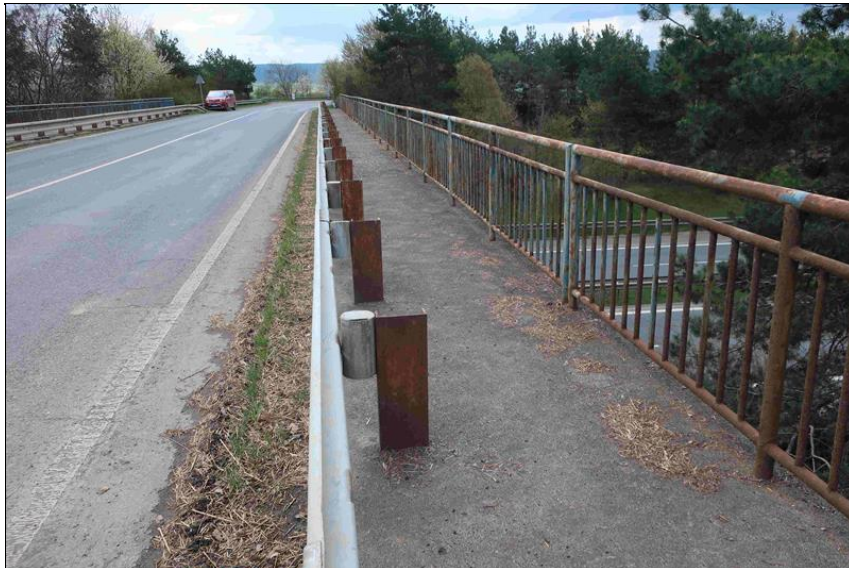
nánosy v odvodňovacím žlábků, koroze sloupků svodidel, koroze pravého zábradlí
