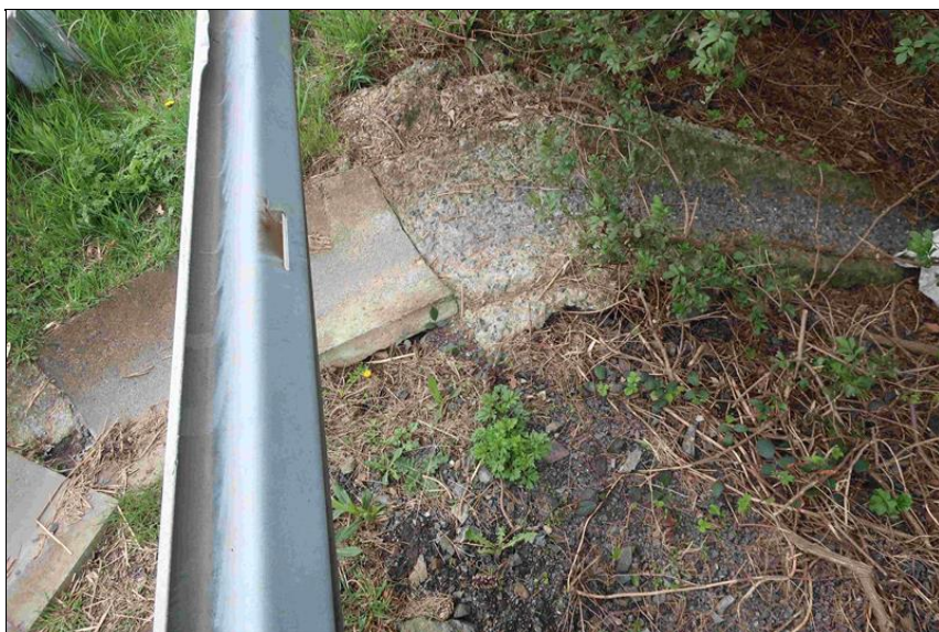
částečně podemletý odvodňovací skluz
