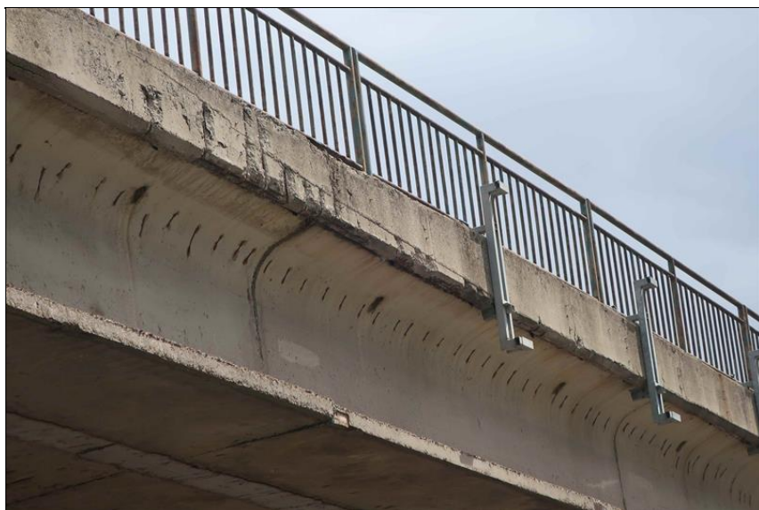
odpadávající krycí vrstva nad korodující výztuží u pravé římsy ve 2. poli
