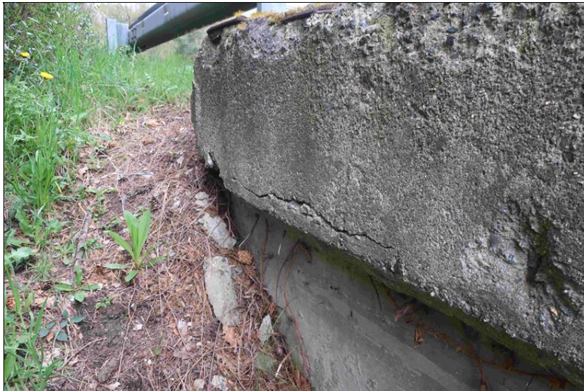
separace krycí vrstvy na spodním líci pravá římsy u O1
