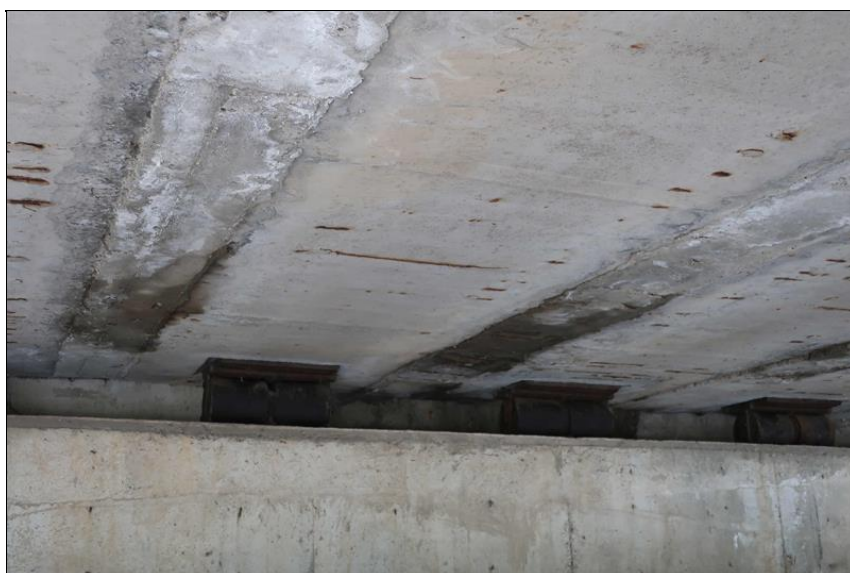
detail průsaků sparami mezi 7.-9. nosníkem nad O1
