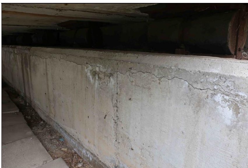
trhlina v hraně ÚP O1 je způsobená rozpínáním koroze výztuže
