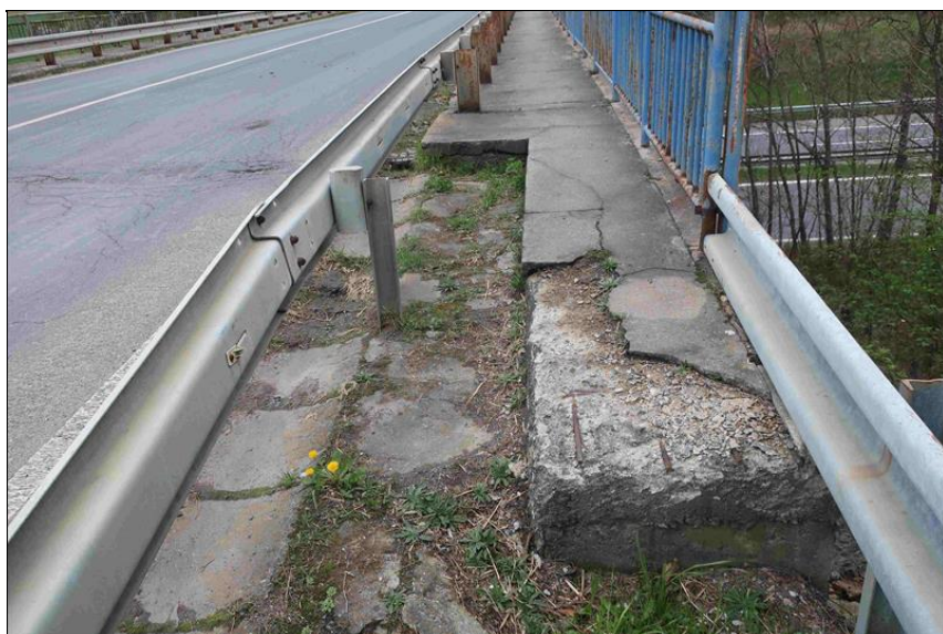
degradace betonu pravé římsy na předmostí za O4
