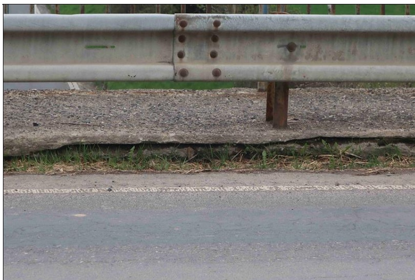
rozpad betonu pravého chodníku
