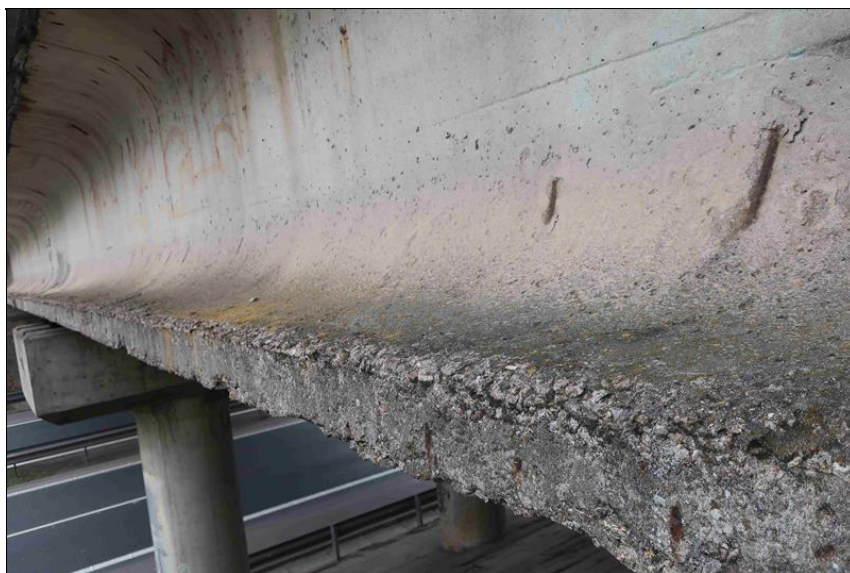
povrchová degradace betonu na vnějším boku 1. nosníku v 1. poli
