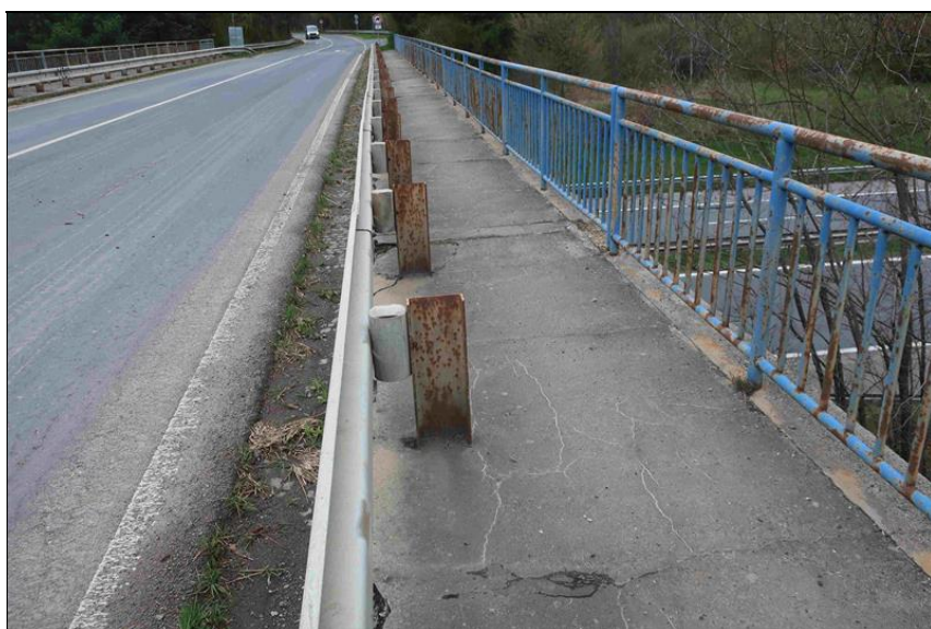
levý chodník koroze sloupků svodidel koroze zábradlí
