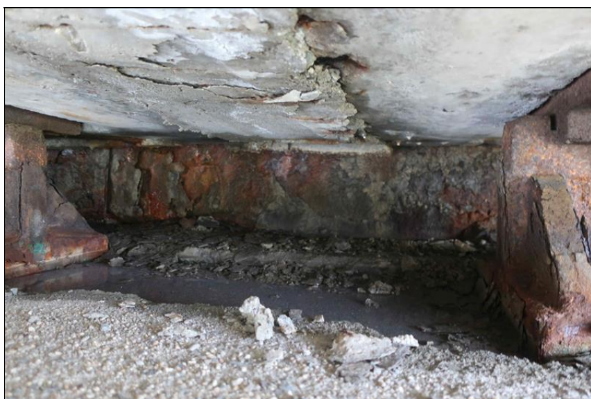
rozpad betonu spáry mezi nosníky v úrovni dolní pásnice výrazné průsaky dilatační sparou u O4 hloubková degradace betonu a intenzivní koroze obnažené výztuže ZZ O4
