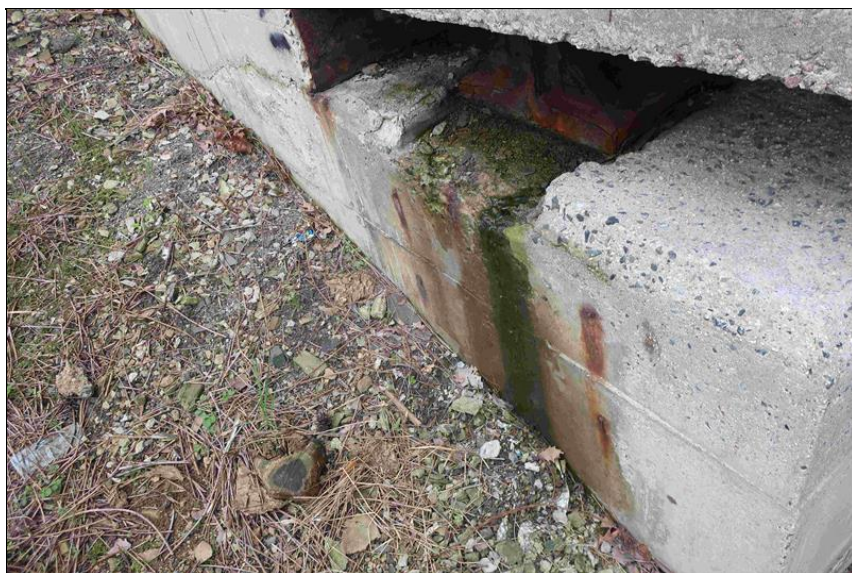
průsaky na levém boku ÚP O4
