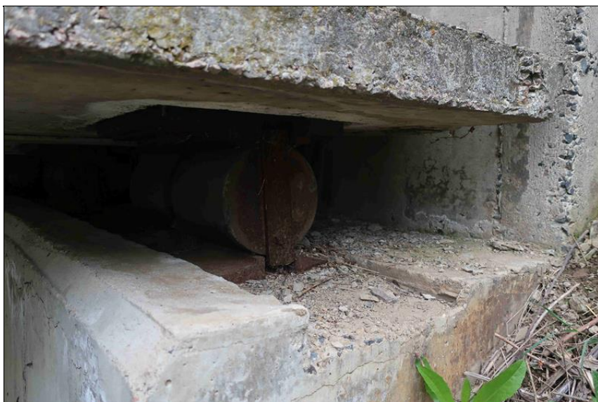
ložisko pod 1. nosníkem na O1 koroduje
