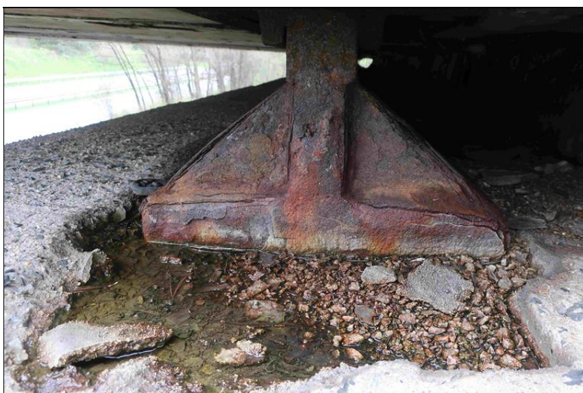
korodující pevné ložisko na O4 pod 9. nosníkem
