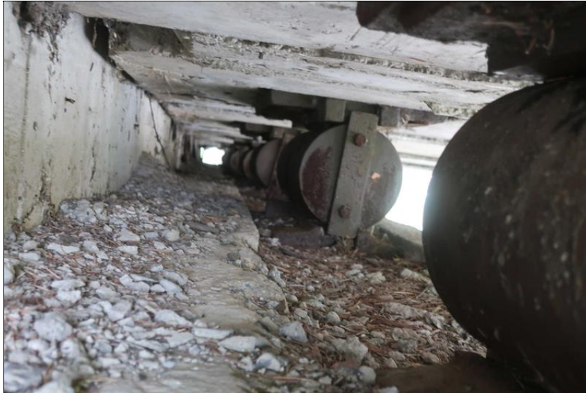
nánosy degradovaného betonu na horním líci ÚP O1
