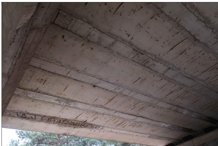
DTTO, průsak sparou mezi 8. a 9. nosníkem v 1. poli
