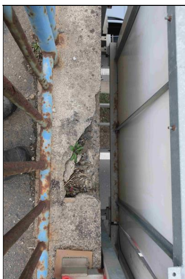
rozpad římsy nad dálnicí D4 v oblasti osazených reklamních poutačů
