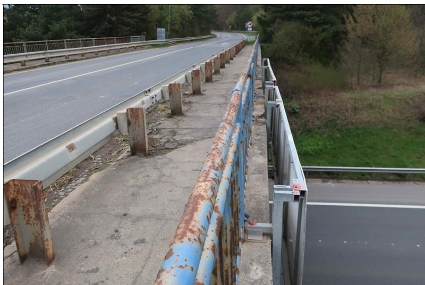
rozpad římsy nad dálnicí D4 v oblasti osazených reklamních poutačů
