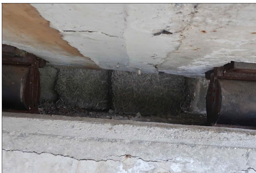
stopy po průsacích na líci ZZ O1
